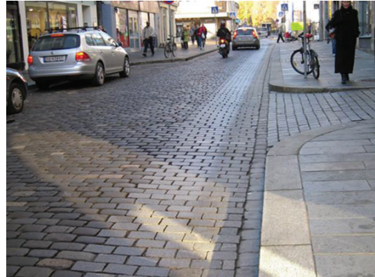
Figur 3.14: Spesiell steinsetting langs sykkelrute med heller eller saget brostein
