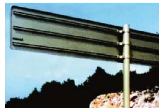
Imagen 11.- Refuerzo perimetral con doble pliegue
