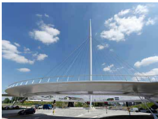
Voorbeeld van verbetering van de doorstroming voor fietsverkeer, openbaar vervoer en autoverkeer, de Hovenring
