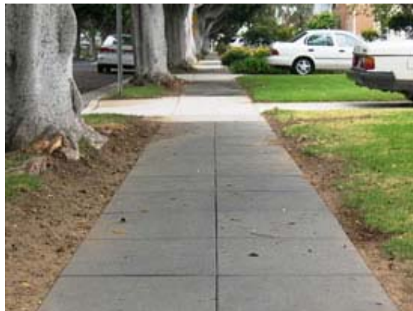
Imag. 4.04 Banqueta de concreto
