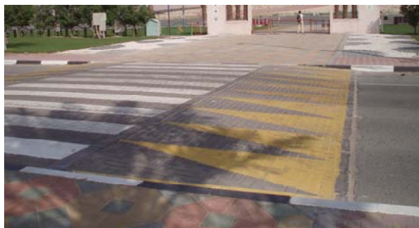
Imag. 4.20 Señalización horizontal en cruceo peatonal elevado
