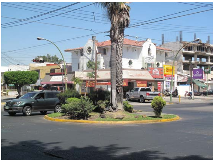
Imag. 3.05 Miniglorieta que disminuye la velocidad vehicular
