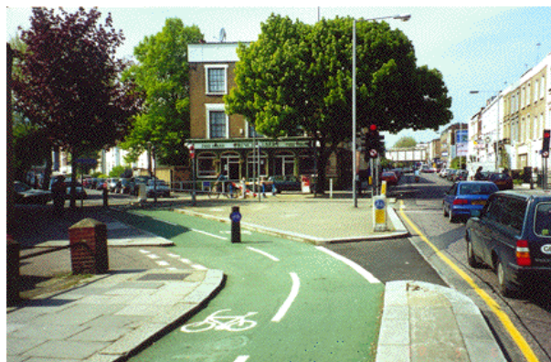
Imag. 5.04 Ciclovía segregada a nivel de arroyo Fuente: Alta Planning, 2009
