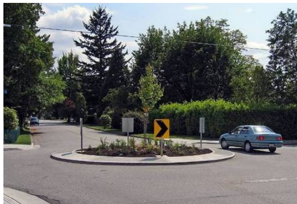
Imag. 5.20 Miniglorieta en intersección
