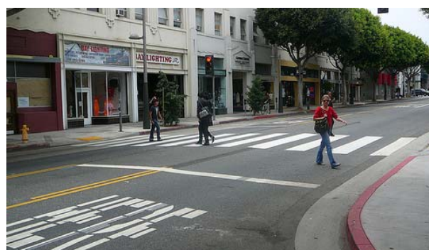
Imag. 4.27 Las líneas de contención o rayas de parada alertan a los vehículos de la presencia de peatones
