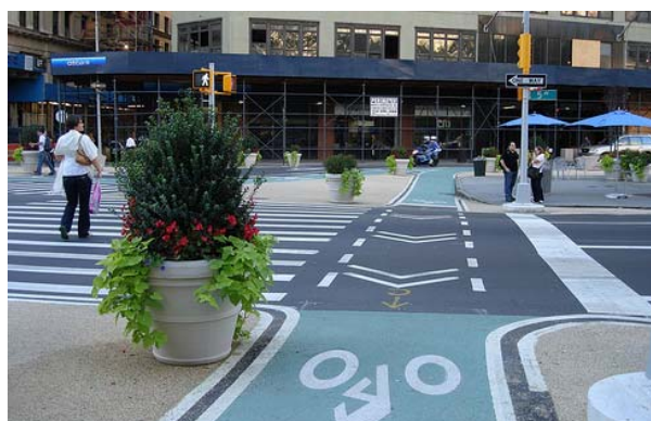
Imag. 4.17 Señalización en crucero que diferencia el espacio de peatones y de ciclistas
