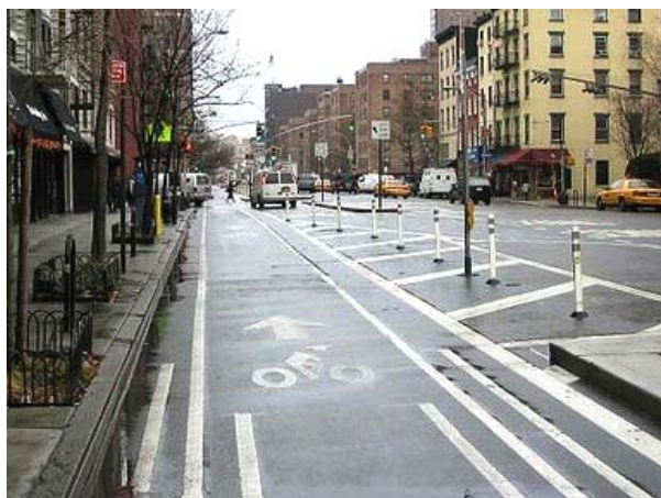
Imag. 5.09 Ciclovia segregada del lado izquierdo
