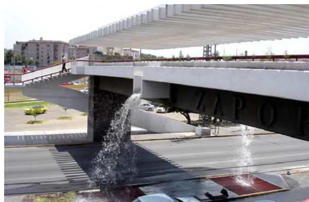
Imag. 4.23 Puente peatonal Fuente: AU Consultores, 2010
