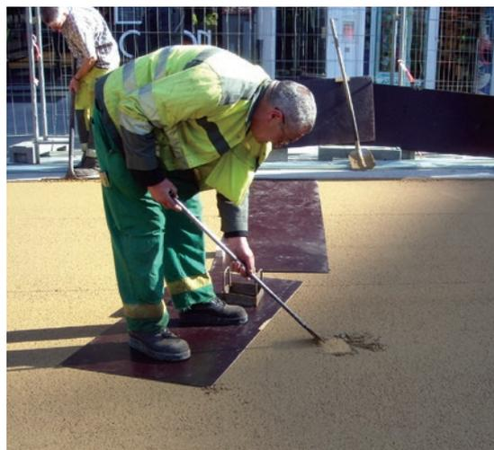
La mise en oeuvre d'un revêtement coloré doit être réalisée avec soin pour garantir un bon rendu esthétique (exemple d'utilisation de plaques en bois lors de la circulation sur chantier).
