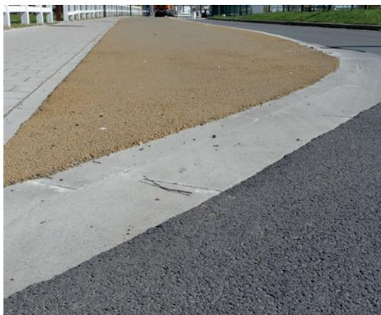
*Revêtement en enrobé bitumineux ocre réalisé sur la partie cyclable d'un aménagement D9.*
