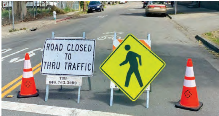
Figura 12. Ejemplo de señalamiento vertical. Fuente Nacto 2020"
