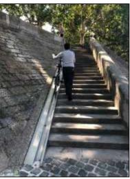
Exemple de goulotte en inox pour descendre sur les berges du Rhône, au niveau de l'intersection Vauban/Sarrail, Lyon3
