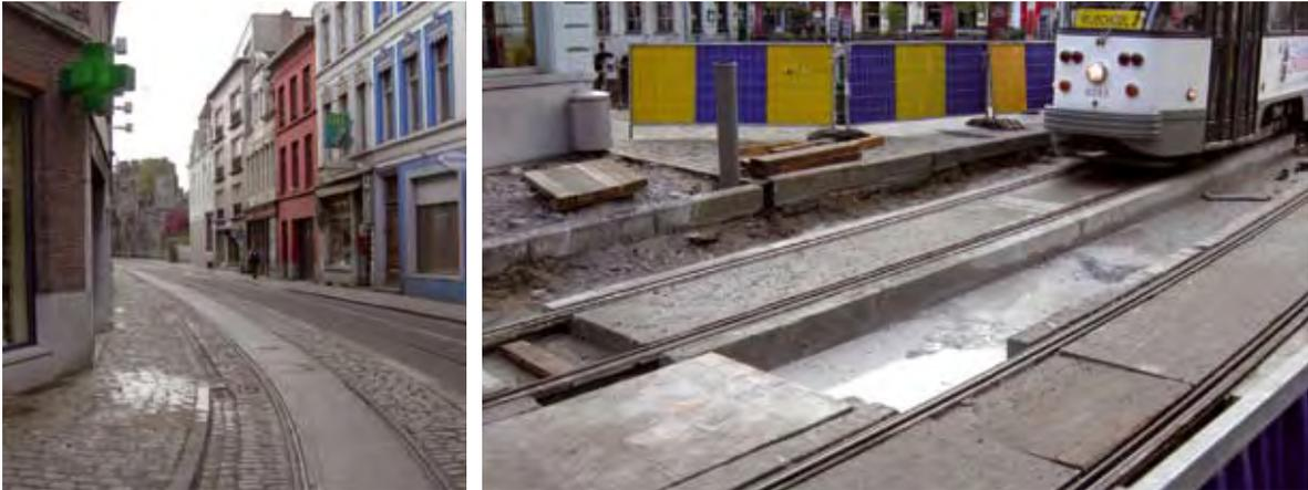
Figure 4.1. et 4.2. – La combinaison de rails de trams et de pavés est extrêmement désagréable pour les cyclistes. L'aménagement d'une zone de confort entre les rails de trams permet d'atténuer le désagrément.
