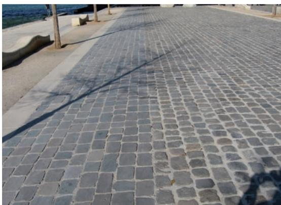
*Bande confort en pavés sciés sur chaussée
