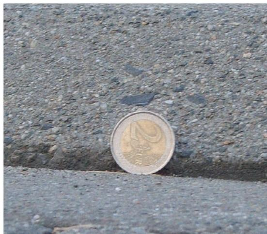
*Le test de la pièce de 2 euros (diamètre de 2,5 cm) permet de mettre cet obstacle en évidence*
