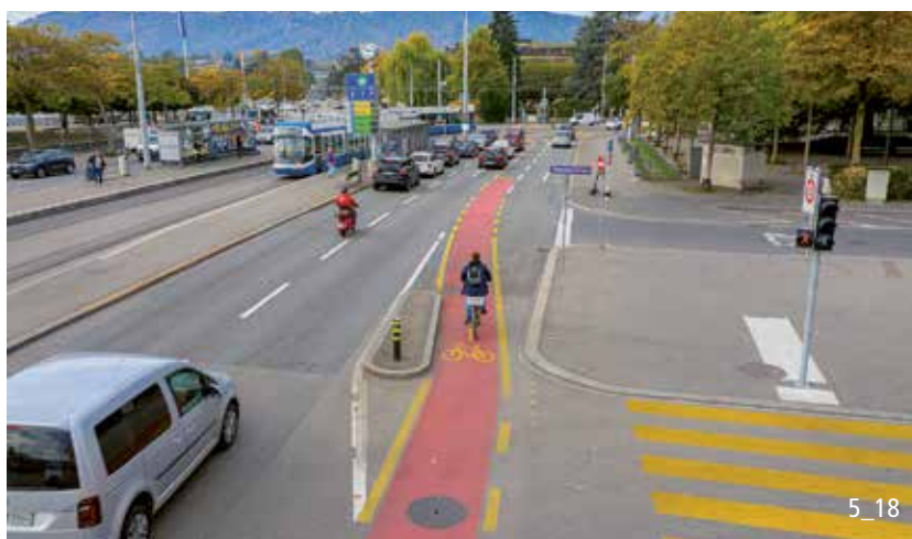
Voie de présélection pour le tourner-à-droite. La mesure constructive empêche les véhicules à moteur de franchir la voie trop tôt.
