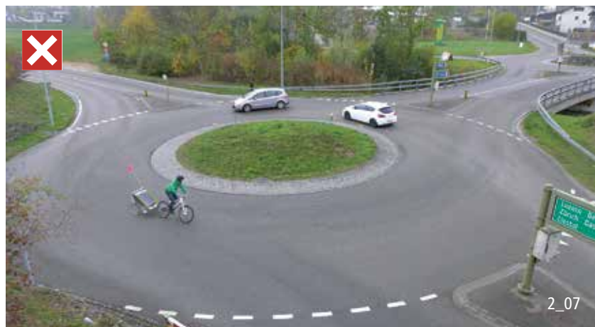
Giratoire dangereux en raison d'une géométrie incorrecte : anneau de circulation trop large, trajectoire directe, vitesse du TIM trop élevée.
