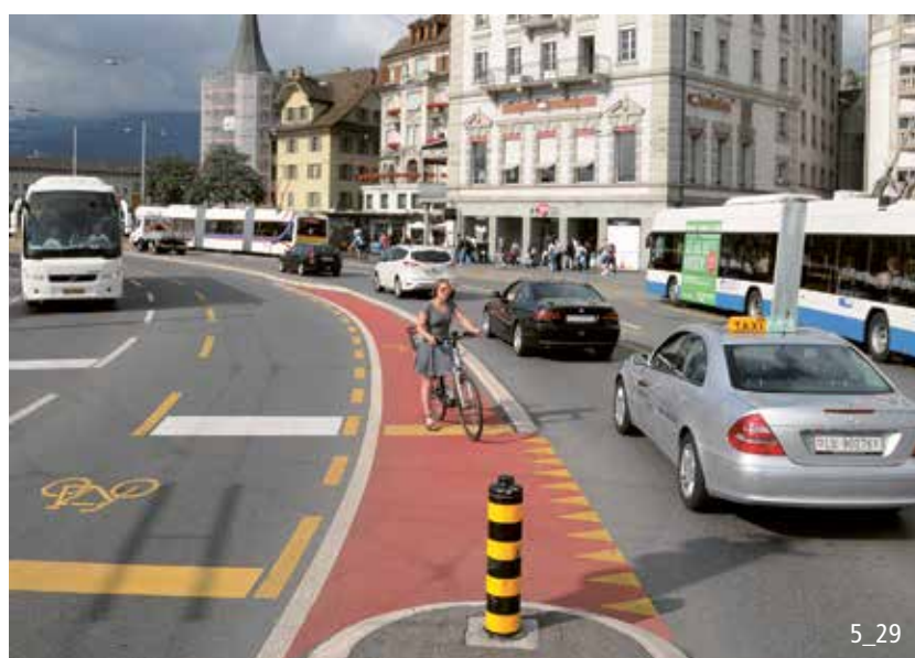
Tourner-à-gauche réservé aux cycles et sécurisé.
