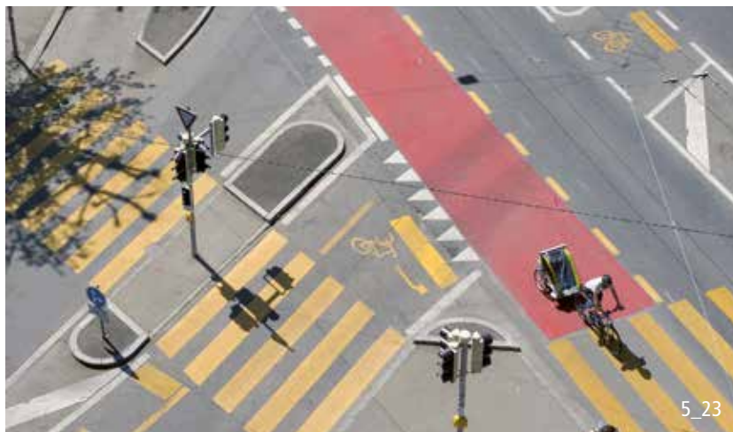
Tourner-à-gauche indirect sur la chaussée.
