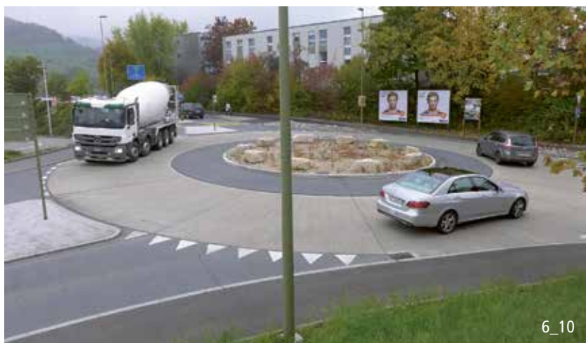
L'anneau de circulation étroit empêche le dépassement des vélos à l'intérieur du giratoire.
