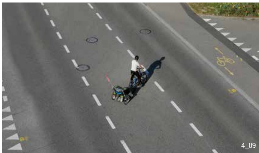
Une largeur \geq 3.50 m améliore grandement la fluidité du déplacement et la sécurité des cyclistes.
