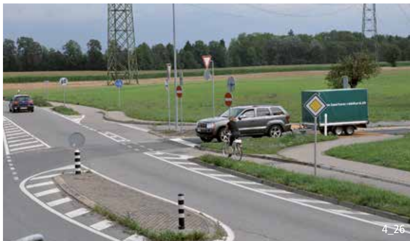
Franchissement prioritaire d'un débouché.
