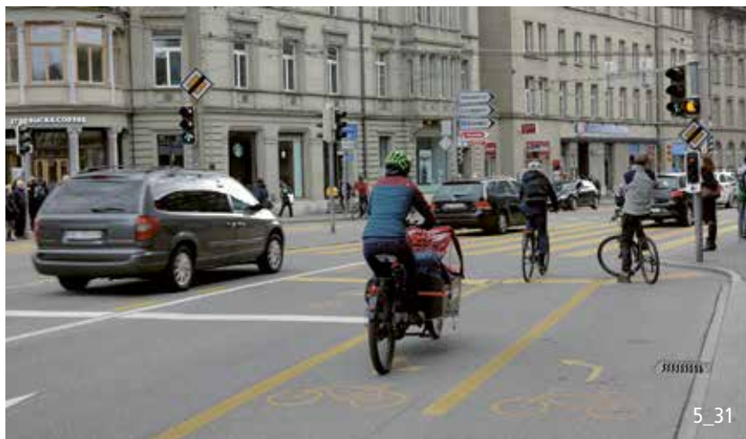
Tourner-à-gauche indirect avec bande cyclable dédiée.
