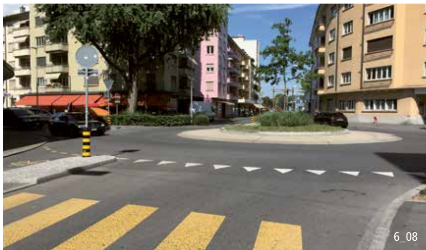
Îlot central situé dans l'axe de la route, anneau central clairement reconnaissable et franchissable dans certains cas.
