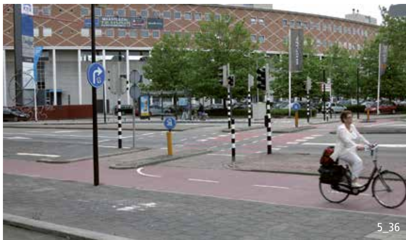
Pistes cyclables avec gués vélo sur toutes les branches du carrefour et SLT (Pays-Bas).
