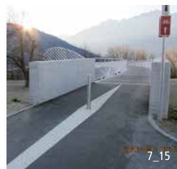
Potelet avec marquage adéquat empêchant le passage des véhicules à moteur sur la rampe.
