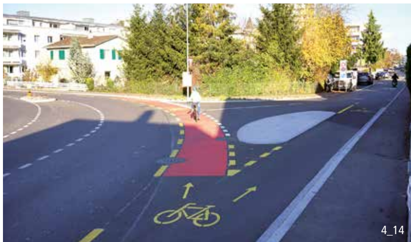
L'îlot de déviation du trafic motorisé met en évidence la trajectoire des cyclistes et assure une progression tout droit confortable et sûre.
