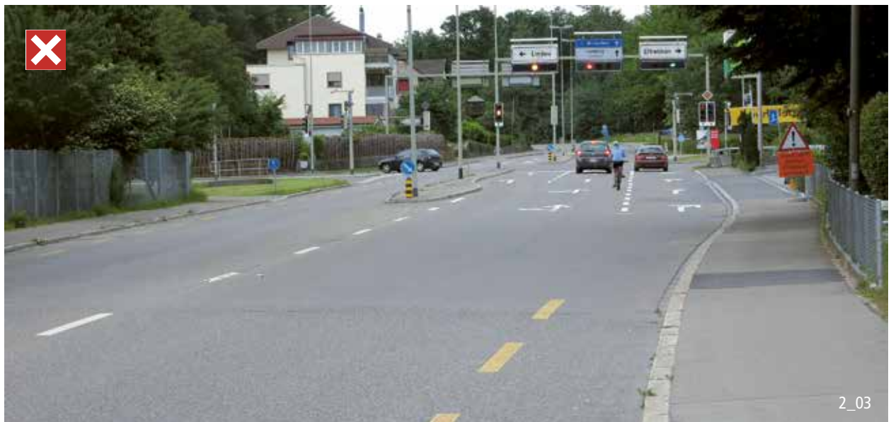
L'infrastructure cyclable s'interrompt avant le carrefour.
