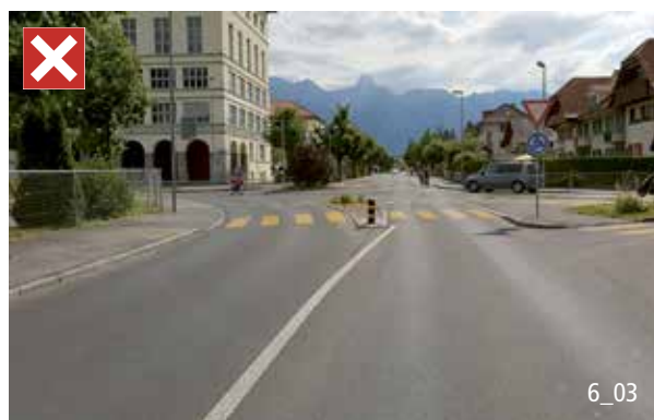
La trajectoire directe entraîne une augmentation de la vitesse à l'intérieur du giratoire.
