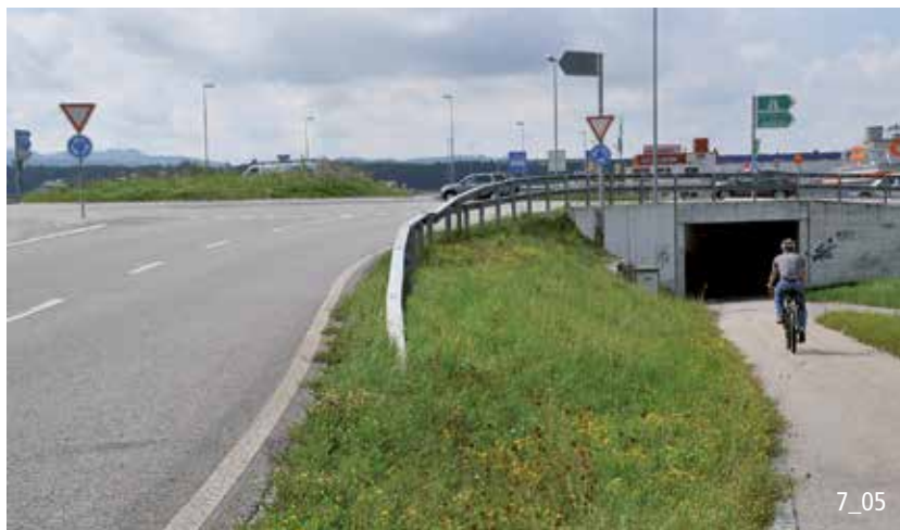
Le passage inférieur permet aux cycles d'éviter le giratoire à deux voies qui n'est pas cyclo-conforme.
