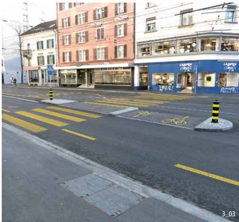
Séparation des parties piétonne et cyclable sur l'îlot de protection : pas d'arêtes sur le passage des vélos.
