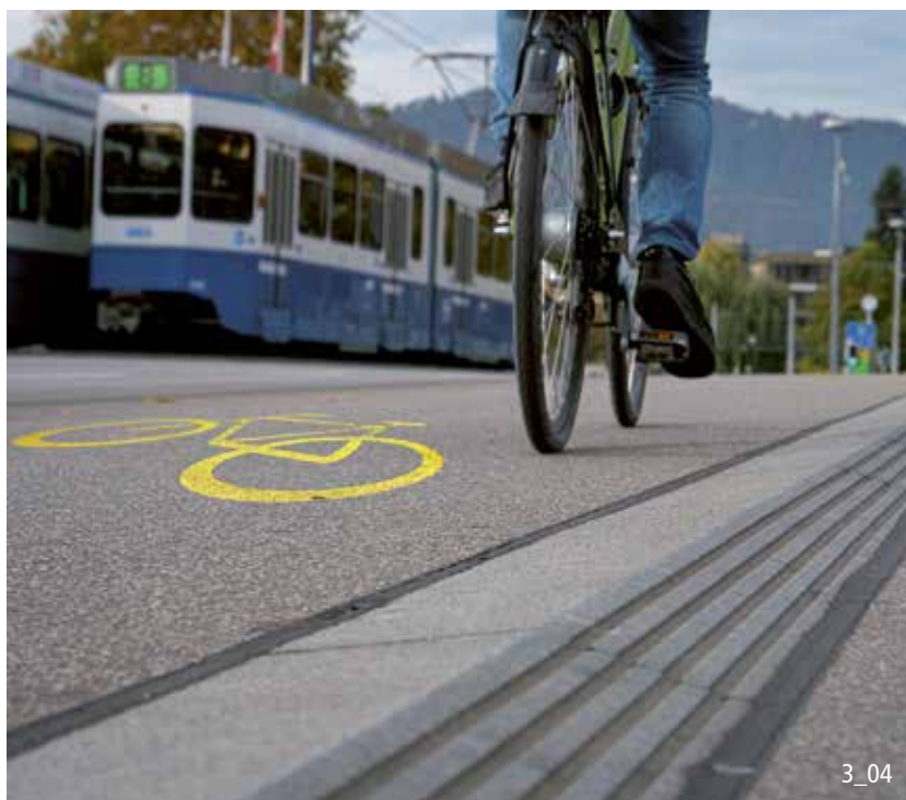
Bordure tactile qui tolère les erreurs pour délimiter la piste cyclable de la surface piétonne. Dans ce cas précis, la hauteur de construction limitée sur le pont implique la réalisation d'une bordure biaise des deux côtés.
