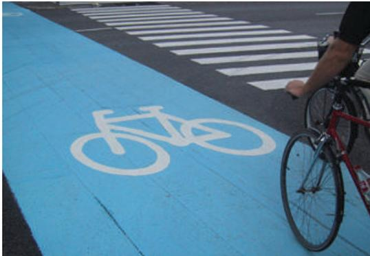
Asfalto con tratamiento termoplastico, pintura o aditivos facilita la identificación de los ciclocarriles.
