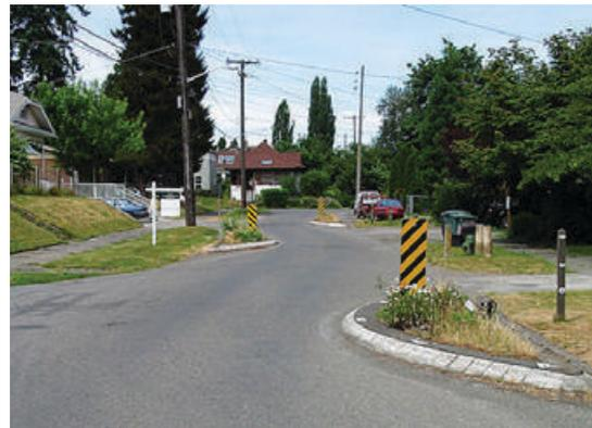
Reductores de velocidad: Angostamiento de la vía que impide el tráfico en línea recta
