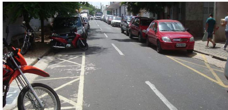
Foto 13: Sinalização horizontal, próximo à R. Riachuelo Fonte: TC Urbes, 2014
