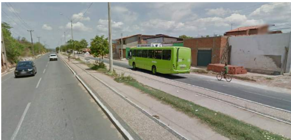
Foto 42: Ciclovia da Av. Pres. Kennedy Fonte: Google Maps, 2012
