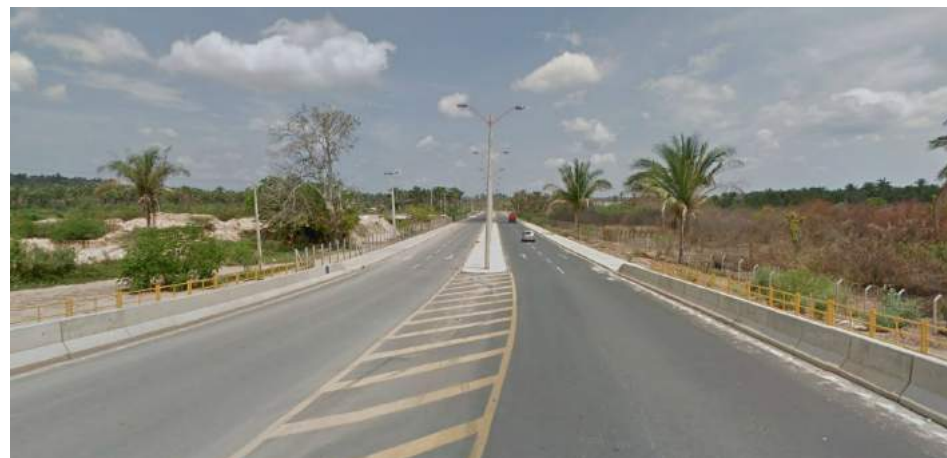
Foto 26: Ponte do Mocambinho, na extremidade do bairro Fonte: Google Maps, 2012
