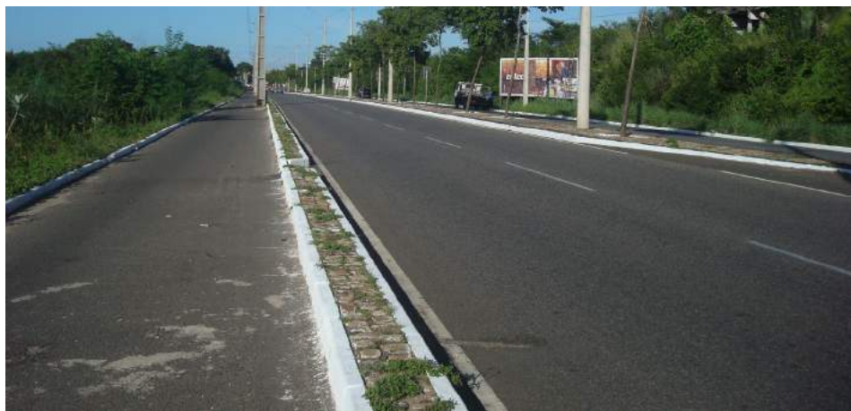
Foto 44: Ciclovia da Av. dos Ipês Fonte: Google Maps, 2012
