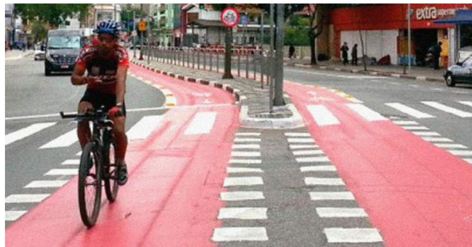
Foto 61: Interferência sinalizada na R. Vergueiro, em São Paulo Fonte: Desconhecida
