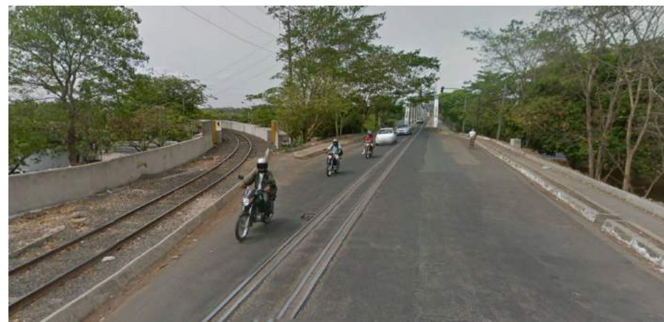
Foto 18: Ponte Metálica, próximo ao lado de Teresina Fonte: Google Maps, 2012
