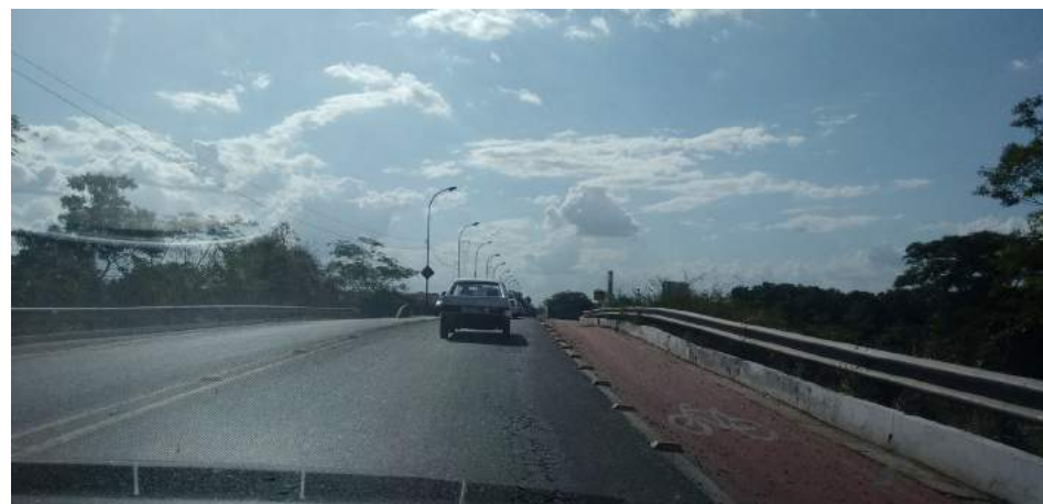
Foto 22: Ciclofaixa da Av. Cajuína, quando se aproxima da ponte Wall Ferraz Fonte: TC Urbes, 2014
