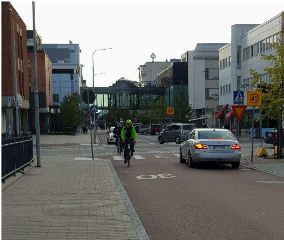
Kuva 115 Joensuussa pyöräkatuna toimivan Kauppakadun poikkileikkaus säilyy muuttumattomana etuoikeutetun Yläsatamakadun ylityksen jälkeen. Risteyksestä puuttuu toistaiseksi Pyöräkatu (E28) ja Pyöräkatu päättyy (E29) -liikennemerkkit (kuva Reijo Vaarala).
