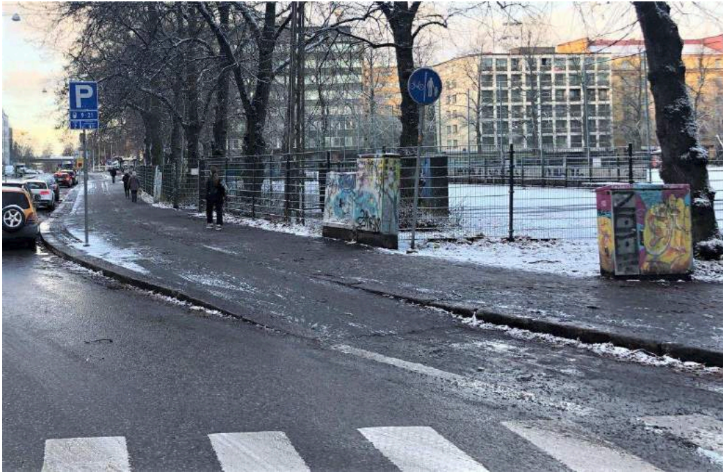
Kuva 196 Pyöräkaistan ja pyörätien saumakohdalla siirtyminen toteutetaan riittävän pitkän siirtymäluiskan avulla (kuva Niko Palo).
