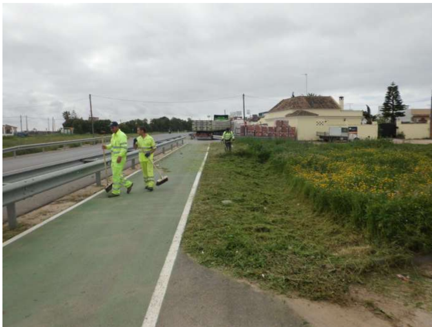
Limpieza de ramas y hojas sobre el carril bici tras labores de conservación de la vegetación. Fuente: Servicio de Carreteras de la Delegación Provincial de Cádiz.
