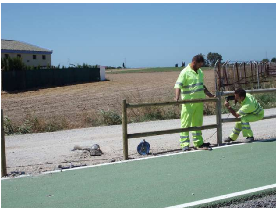
Reposición de barandilla en el carril bici de la A-491.
