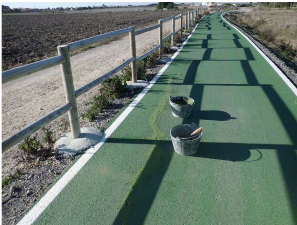
Sellado de grietas en el carril bici de la A-491.
