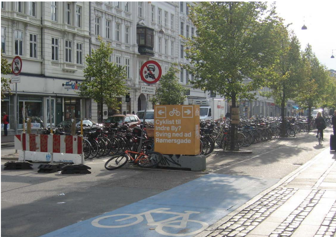
Kuva 31. Selkeä työmaan aikainen opastus auttaa pyöräilijää löytämään kiertoreitin. Esimerkki Kööpenhaminan metrotyömaalta (kuva: WSP Finland Oy).
