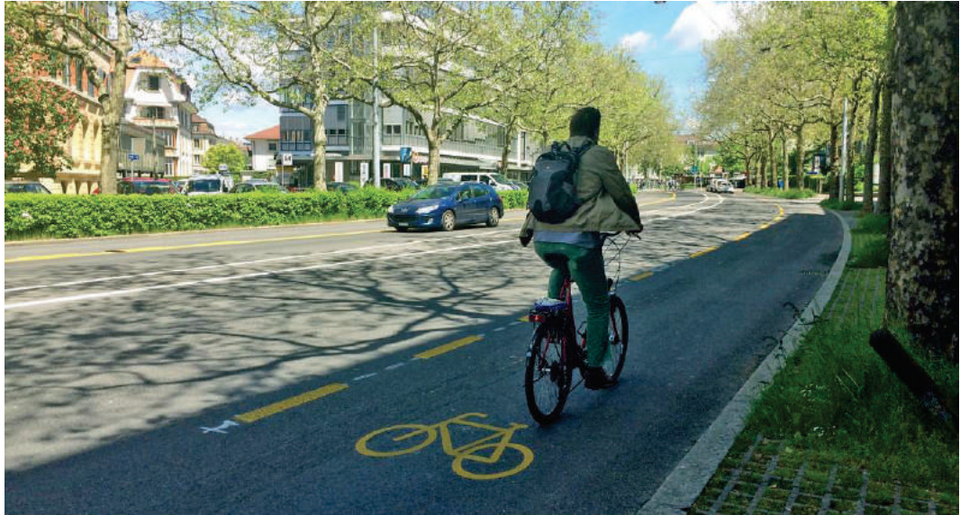
Abb. 34 Breiter Radstreifen (2.50 m breit), Nordring Bern (CH)
