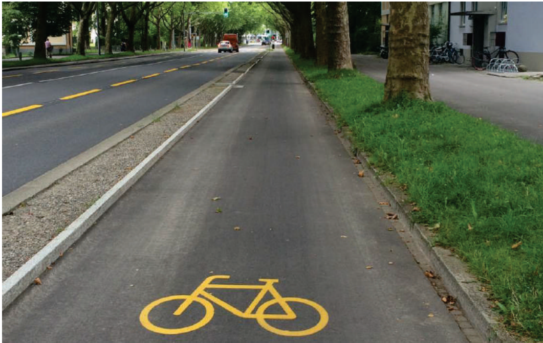
Abb. 18 Strassenbegleitender Richtungsradweg (2.50 m breit) auf der „Velohauptroute Wankdorf“ im städtischen Raum Bern (CH)
