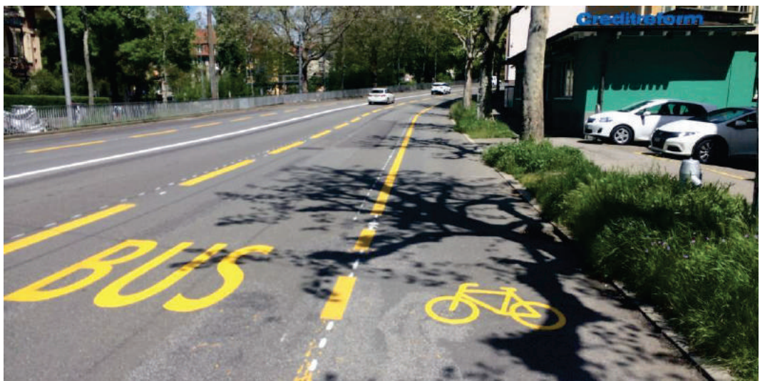
Abb. 35 Bussstreifen mit breitem Radstreifen (2.50 m), Nordring Bern (CH)
