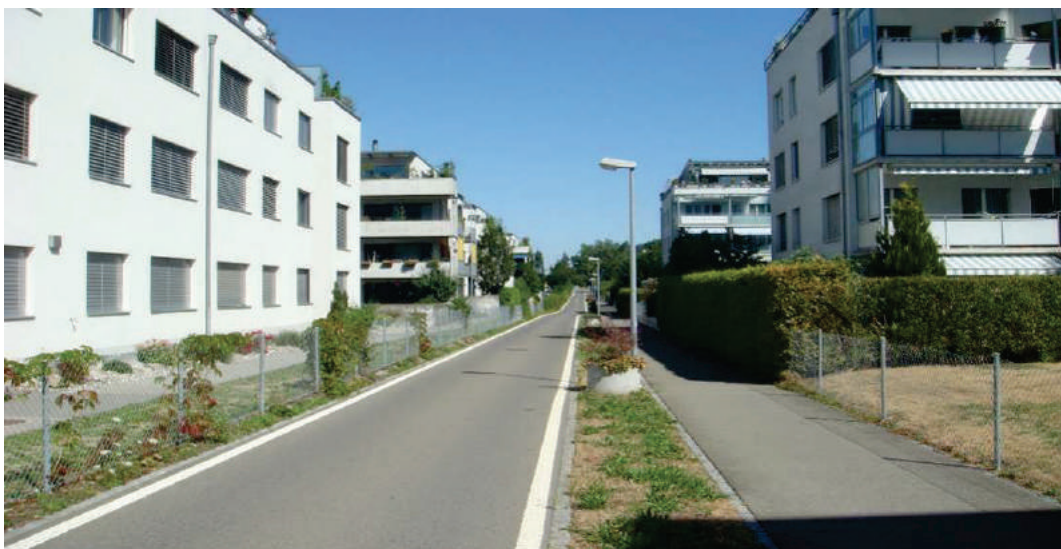
Abb. 11 Eigenständig geführter Zweirichtungsradweg (3 m breit) in einem Vorort auf der Veloverbindung Heimberg – Thun (CH)
