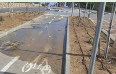
בשביל אופניים בין אבני שפה יש להקפיד על ניקוז, למניעת הצטברות מים ובוץ
