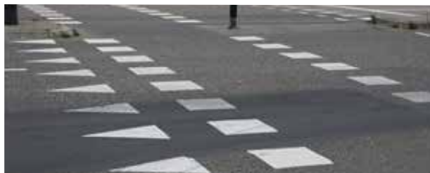
Sinistra 47 : pista ciclabile con diritto di precedenza contrassegnata da segnaletica orizzontale a blocchi.
